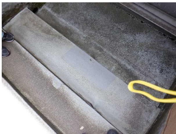
⑦ 屋上階段
