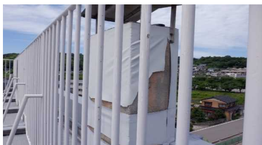
⑤屋上煙突
