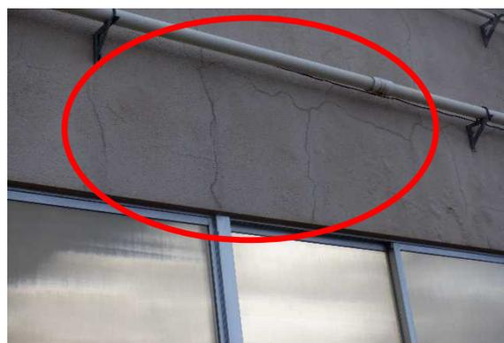
○サッシの上から水滴がぽたぽたと落ちてきます。右は教室の外壁です。多くのひび割れが確認できます。
