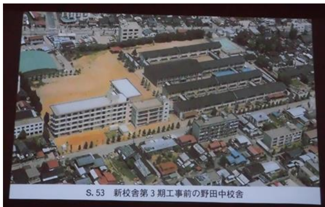
昭和53年野田中第3期工事中
